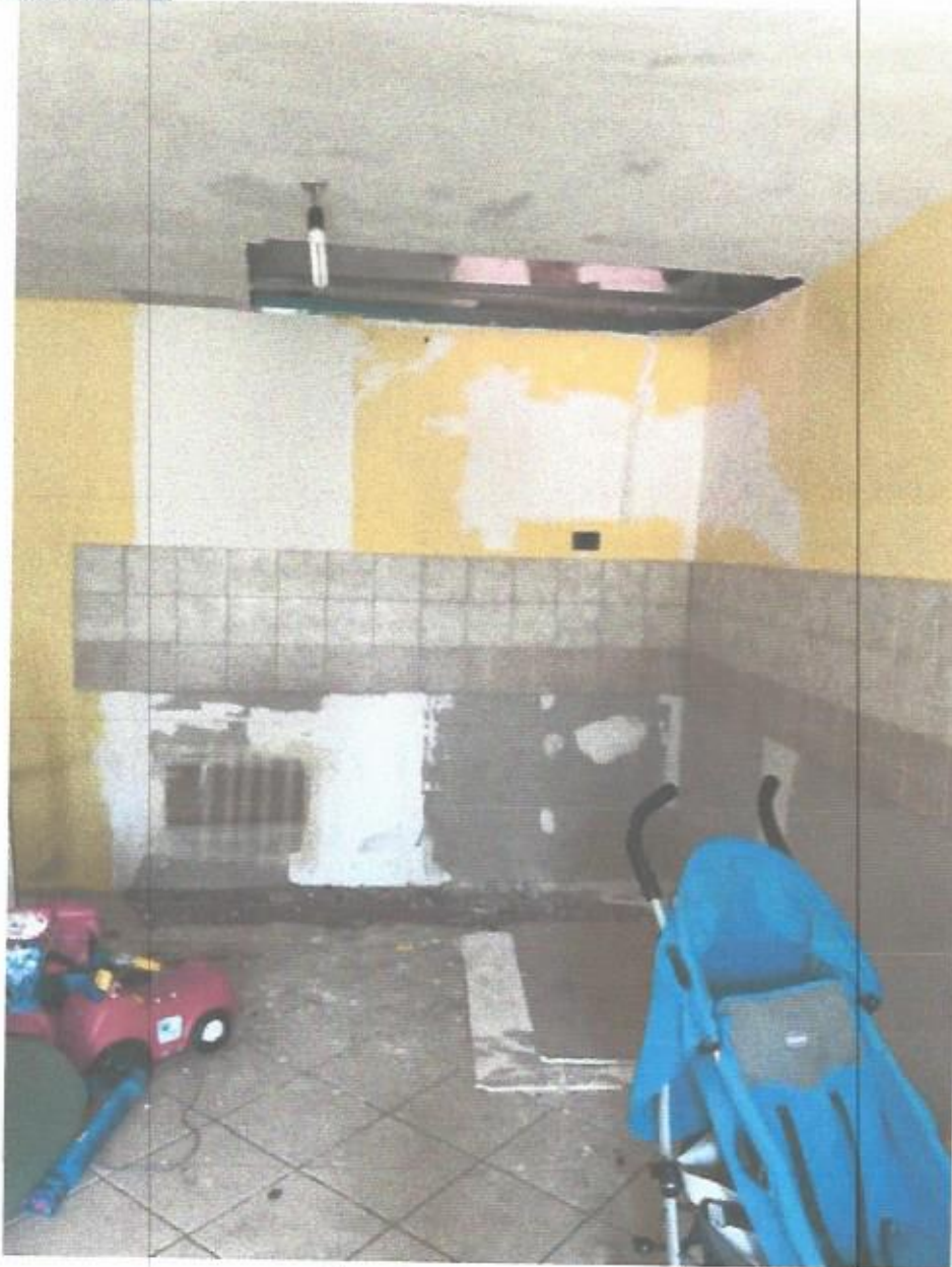
Vano piano terra p.lla 467/1
