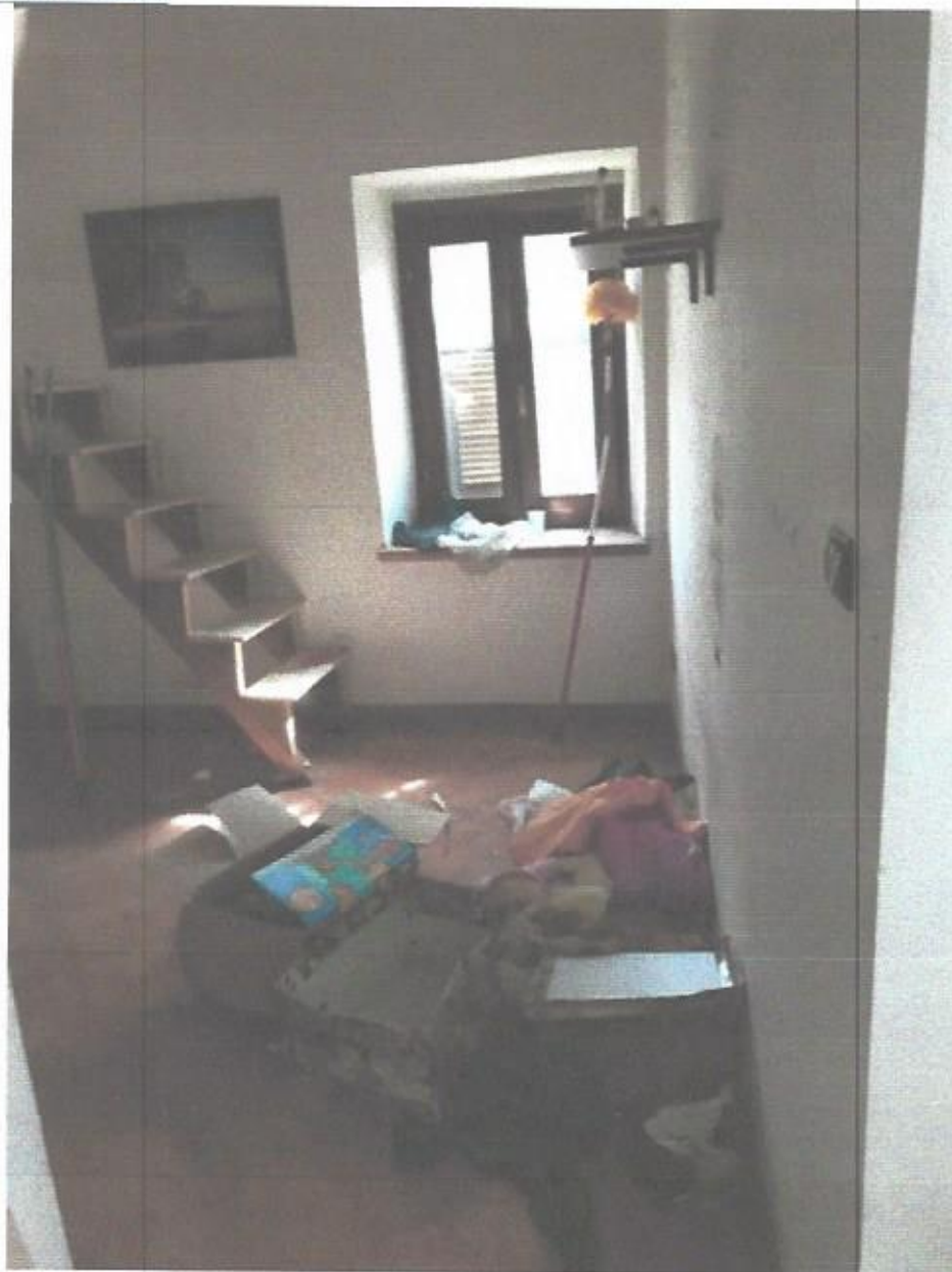
Camera piano primo p.la 466 con scala di accesso al sottotetto
